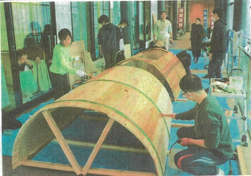
木桶蒸留器を模した休憩所を製作する宮崎県建築士会都城支部員と都城高専生 || 都城中町
